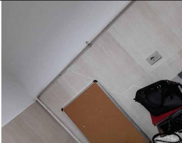
الشروخ بالحائط الموازي للحائط السابق بجوار العمود بالدور الاول
